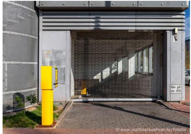
Abb. 2 Gut erreichbare Bedieneinrichtung
