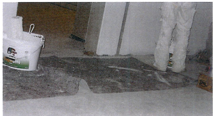
Abb. 5: Faltenbildung eines Malerabdeckvlieses aufgrund unzureichender Befestigung auf dem Fußboden unmittelbar vor einer Türöffnung
