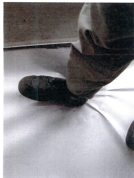
Abb. 7: Überdeckte und nicht gesicherte Bodentanks
