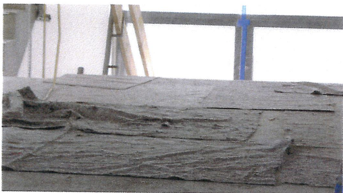
Abb. 8: Stolperstelle auf dem Treppenpodest aufgrund einer verdeckten elektrischen Leitung
