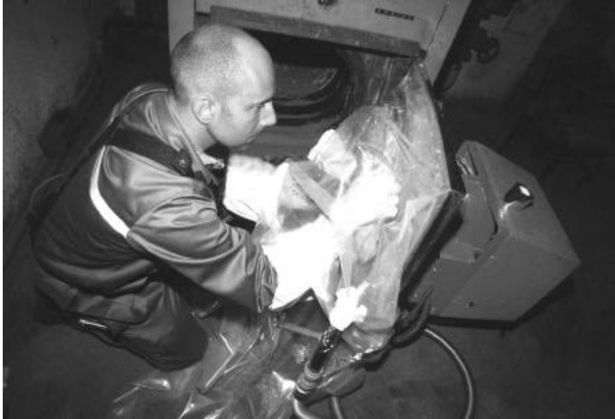
Bild 2: Entfernung der Brennertürdichtung
