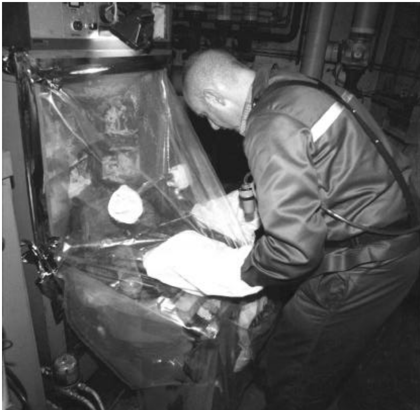
Bild 3: Entfernung der Dichtungen an den Reinigungsöffnungen der Rauchgaszüge
