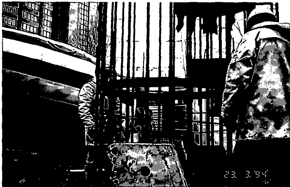
Abbildung 44: Bohrpfahl bewehren (D 43)
