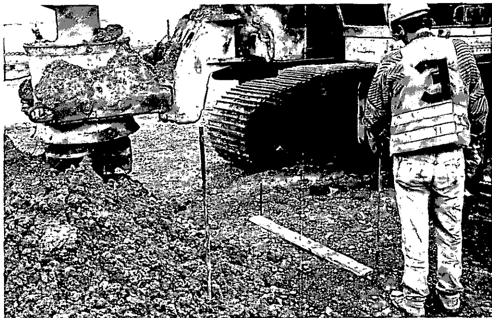
Abbildung 16: Bohrlochmarkierung einschlagen (D 2)
