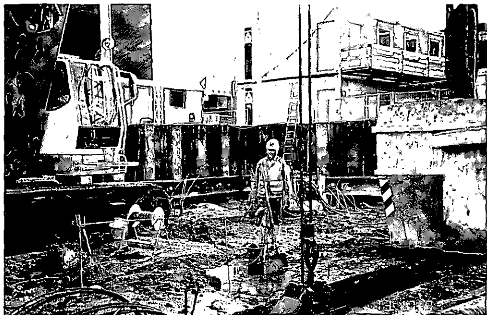
Abbildung 36: Nebenarbeiten, Schlitzwandtiefe messen (D 32)
