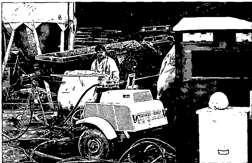
Abbildung 52: Torkret-Maschine bedienen (D 55)
