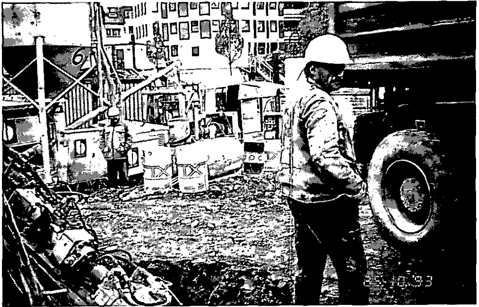
Abbildung 42: Ankerbohrung neben der Baustelleneinfahrt überwachen (D 38)
