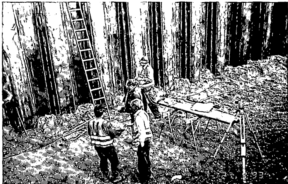
Abbildung 26: Ankerlöcher einmessen (D 17)
