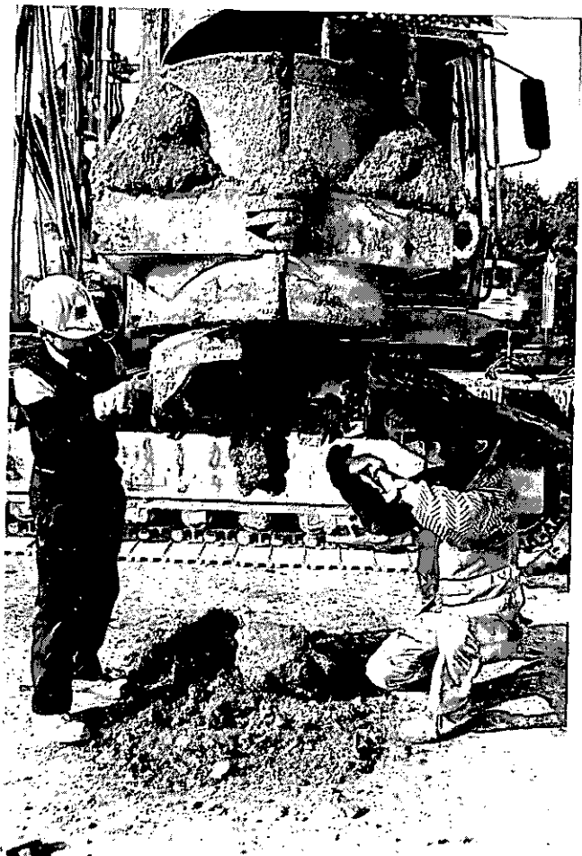
Abbildung 19: Bohrmeißel auswechseln (D 6)
