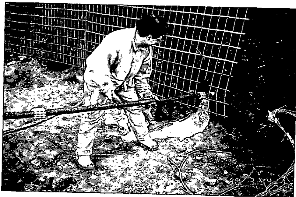
Abbildung 54: Erdnagel einbauen (D 57)
