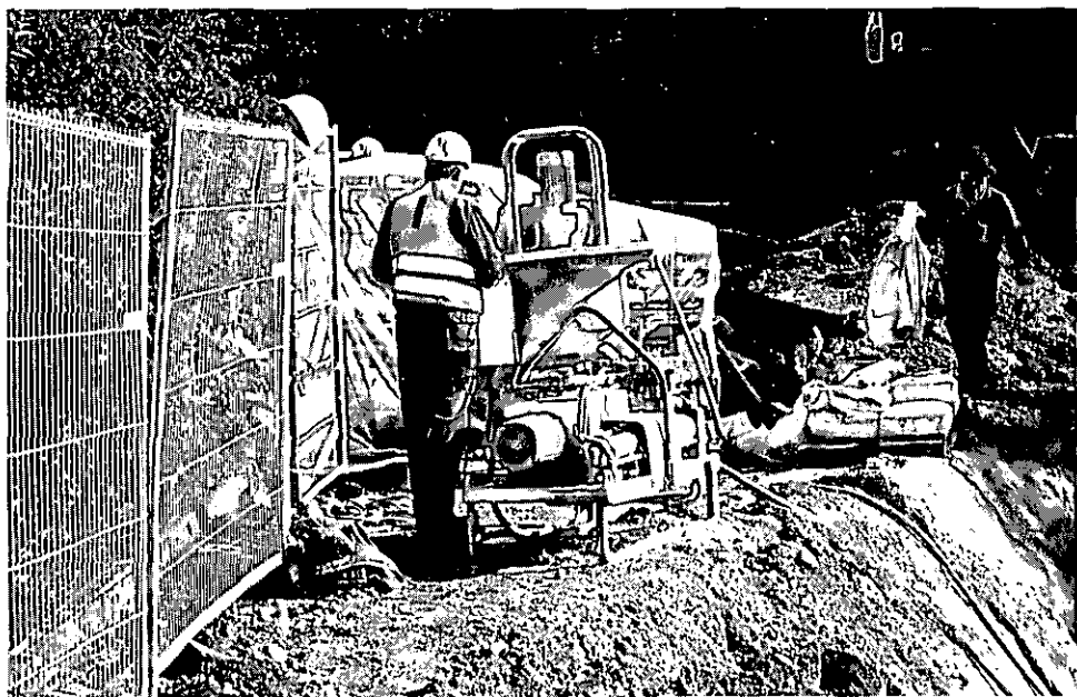
Abbildung 23: Injektionspumpe bedienen (D 11)
