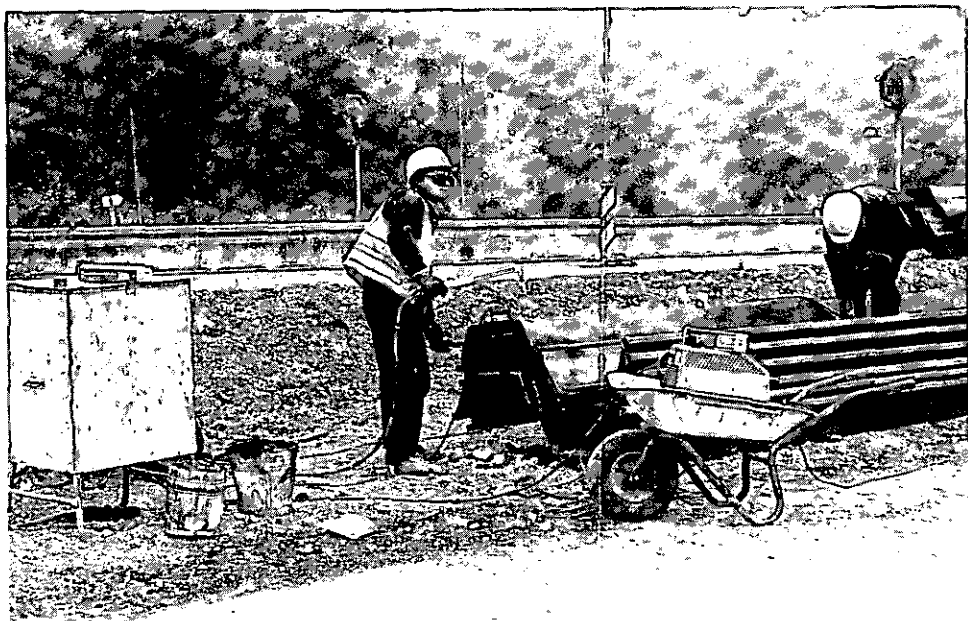
Abbildung 15: Spülrohre montieren (D 1)
