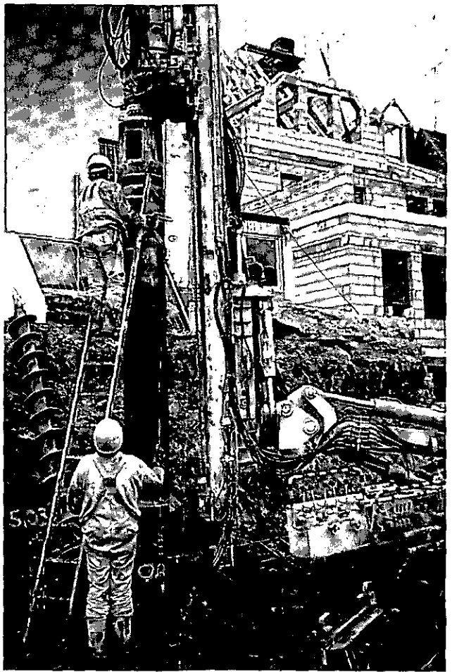
Abbildung 38: Hüllrohr anschlagen (D 34)
