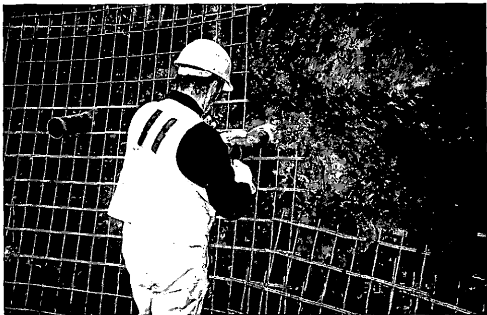
Abbildung 50: Spritzbetonbewehrung anbringen (D 53)
