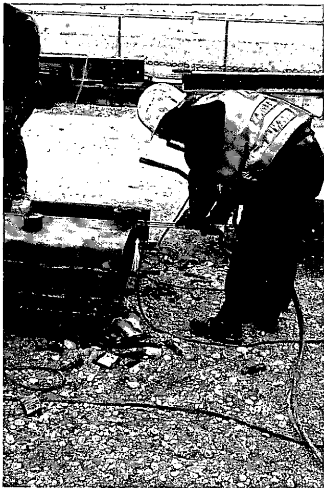
Abbildung 18: Spülrohrleitungen abbrennen (D 5)
