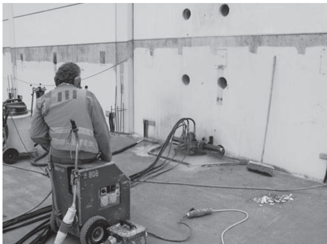
Abbildung D.25: Kernbohrgerät bedienen
