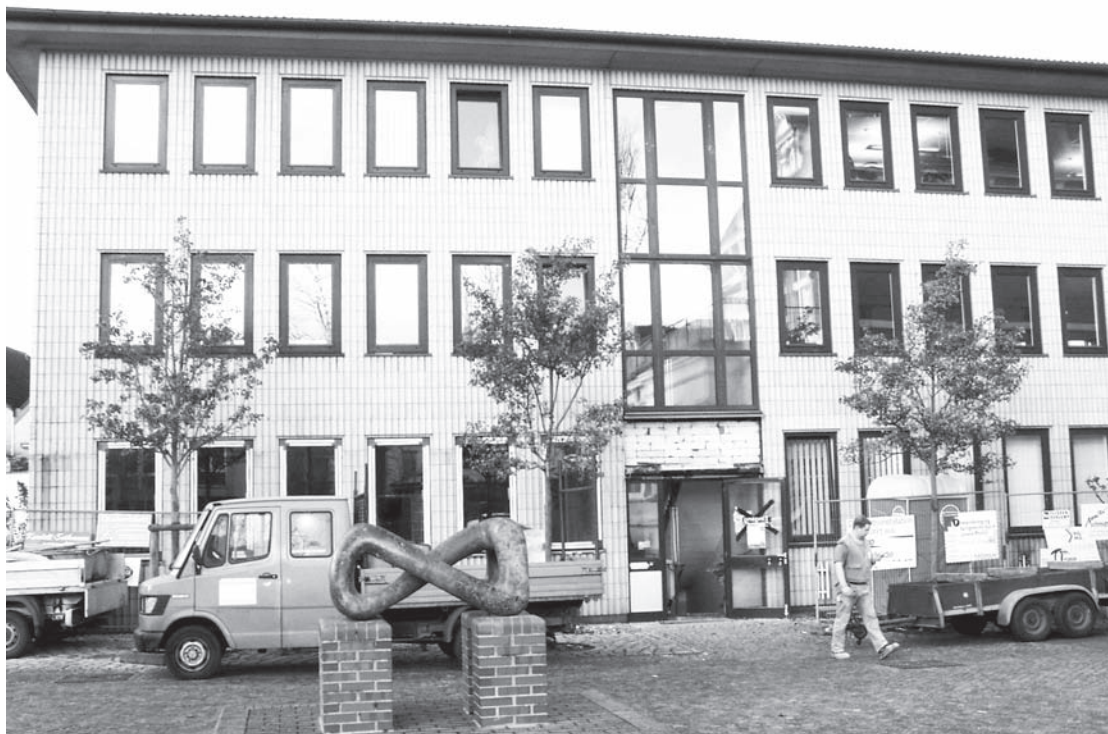
Abbildung D.9: Baustelle 14
