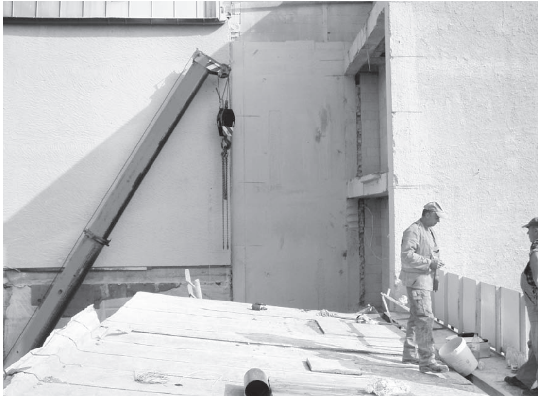
Abbildung D.1: Baustelle 1
