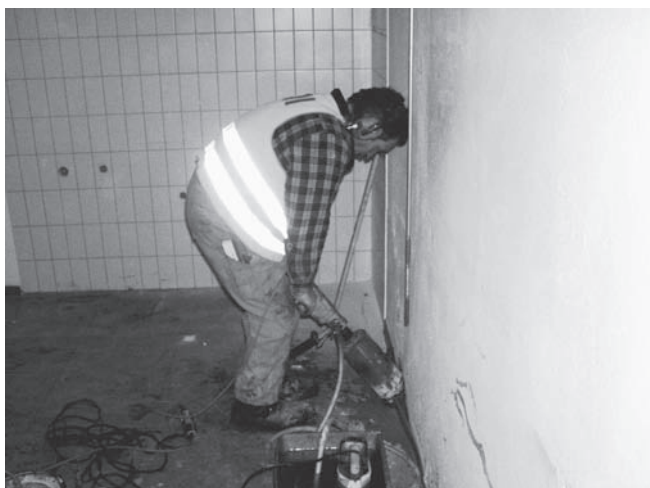
Abbildung D.31: Kernbohrung durch Mauerwerk
