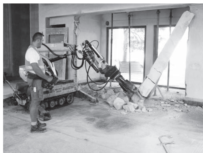
Abbildung D.15: Abbruchbagger fernsteuern
