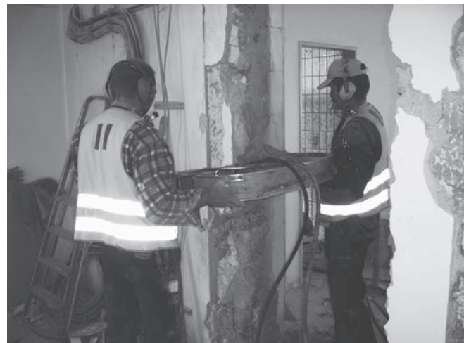
Abbildung D.30: Abbruch einer Betonwand mit Hydraulikzange
