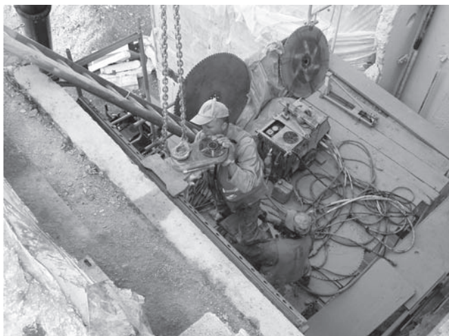
Abbildung D.11: Wandsäge umbauen
