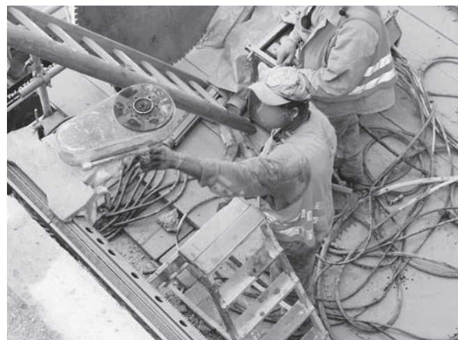
Abbildung D.10: Wandsäge umbauen
