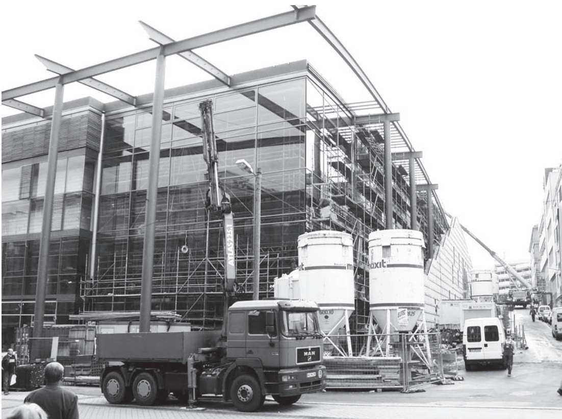
Abbildung D.7: Baustelle 10
