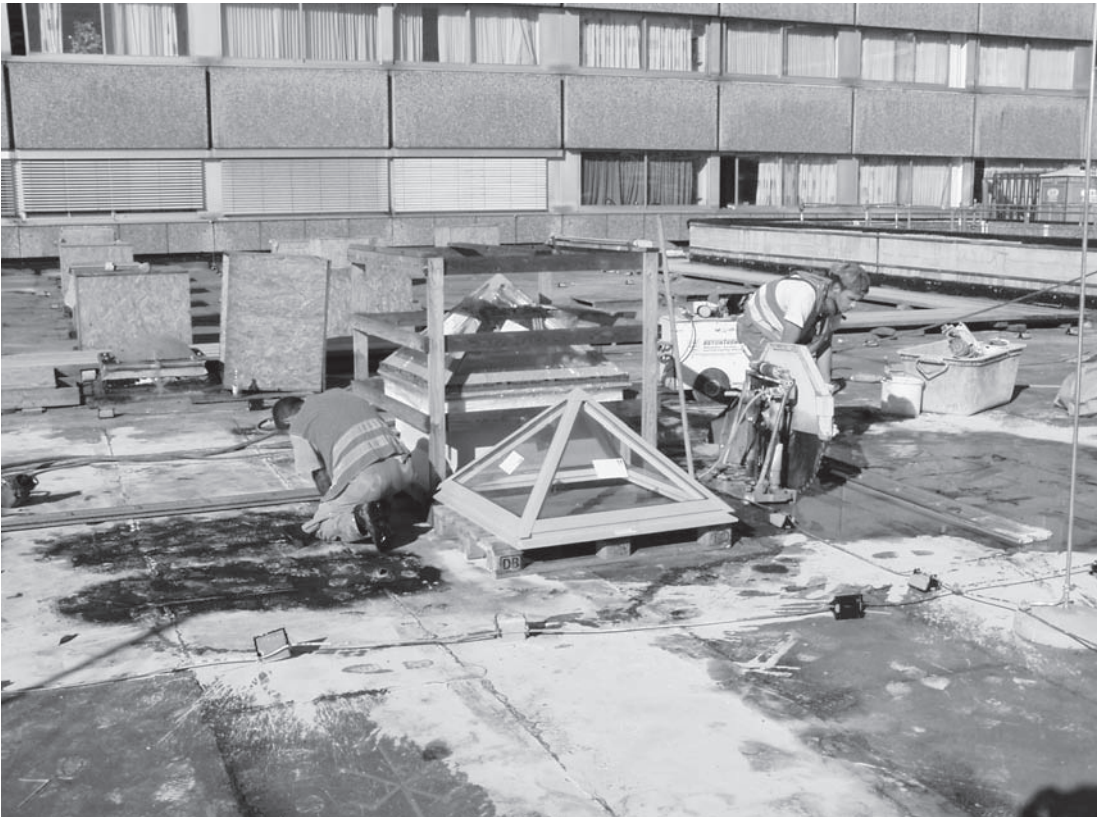
Abbildung D.3: Baustelle 3
