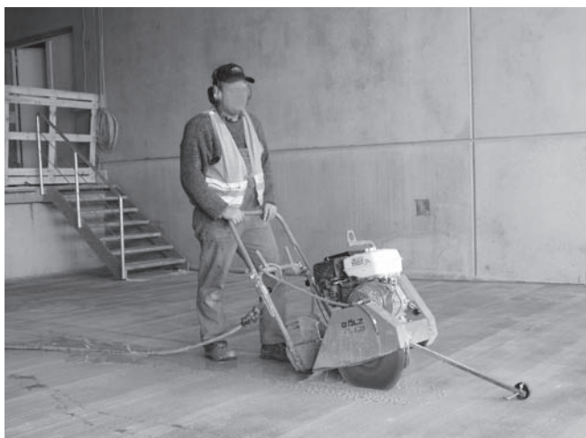
Abbildung D.21: Fugenschneider bedienen
