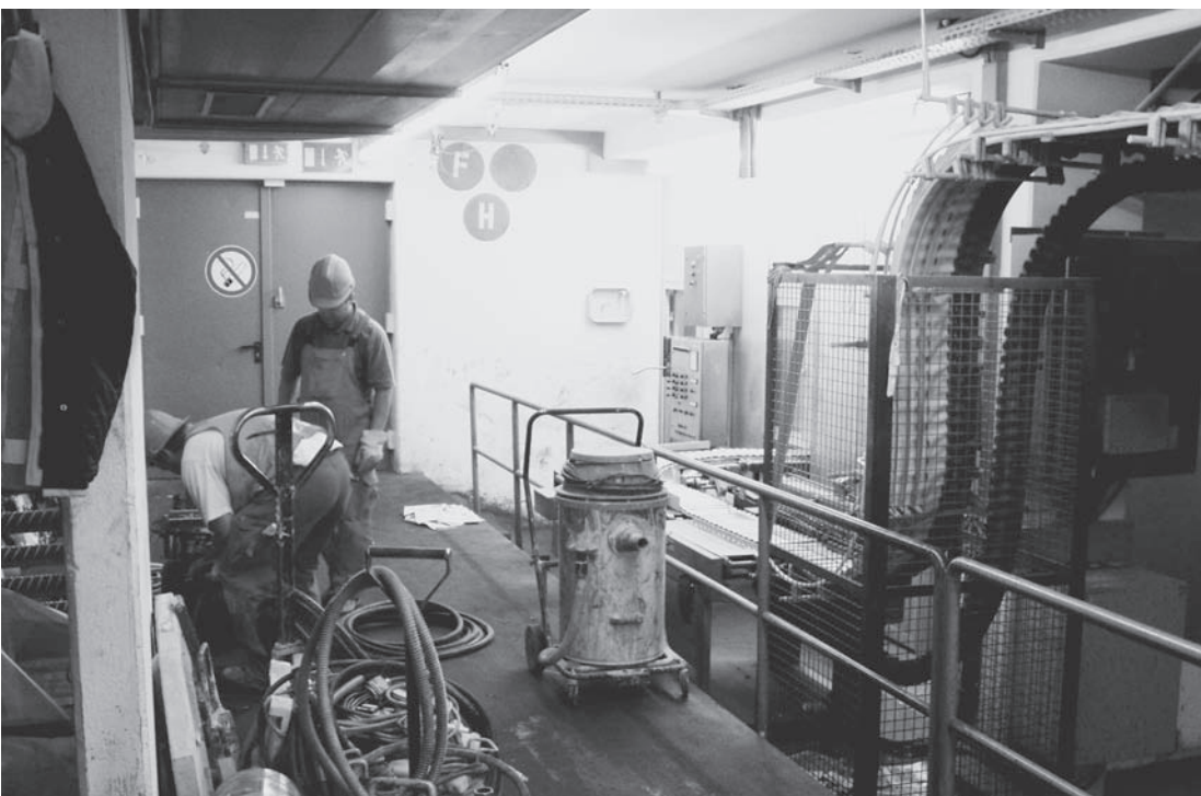
Abbildung D.4: Baustelle 5
