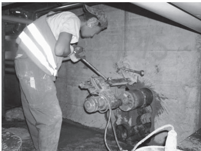
Abbildung D.14: Kernbohrgeräte bedienen
