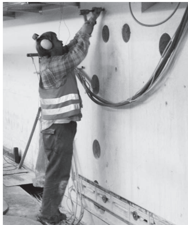
Abbildung D.17: Befestigungsbolzen einschlagen
