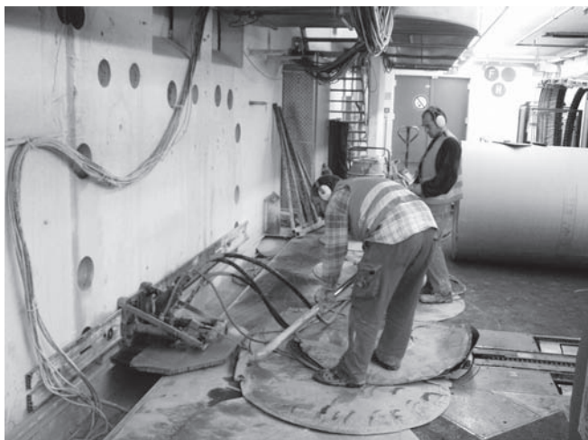
Abbildung D.18: Wasser mit Industriesauger absaugen
