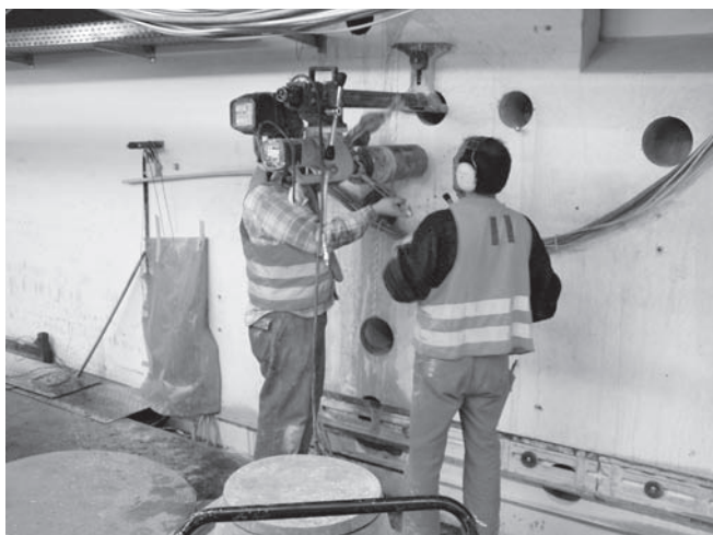
Abbildung D.16: Kernbohrgerät montieren
