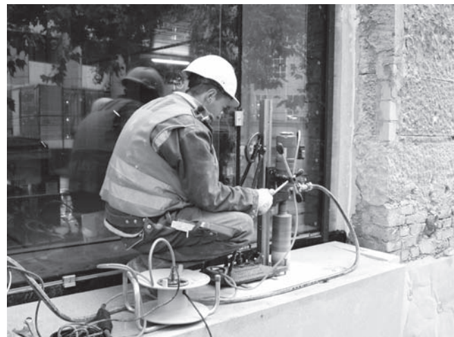
Abbildung D.27: Kernbohrung an der Außenfassade
