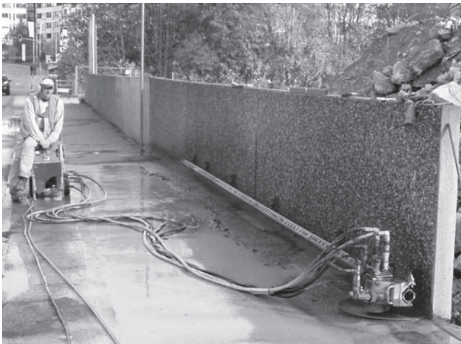
Abbildung D.23: Beton säge bedienen
