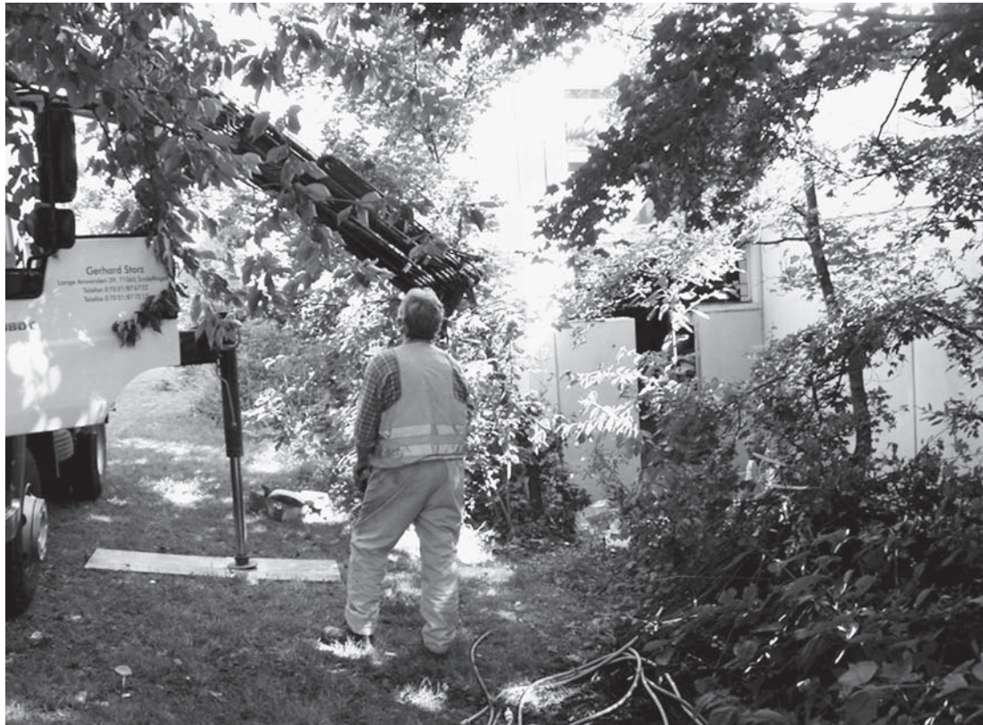
Abbildung D.2: Baustelle 2
