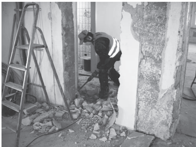
Abbildung D.29: Betonwand mit Stemmgerät einstemmen
