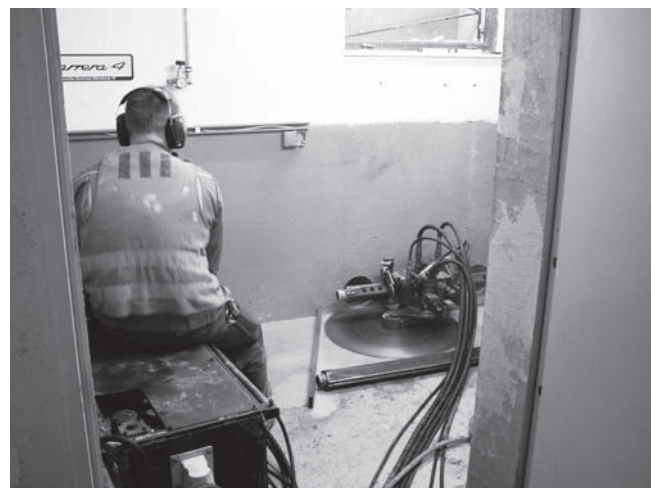
Abbildung D.28: Betonsäge bedienen
