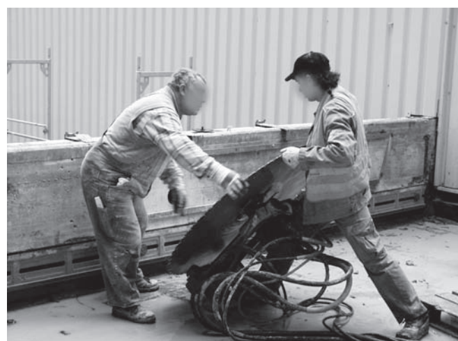
Abbildung D.22: Betonsäge montieren
