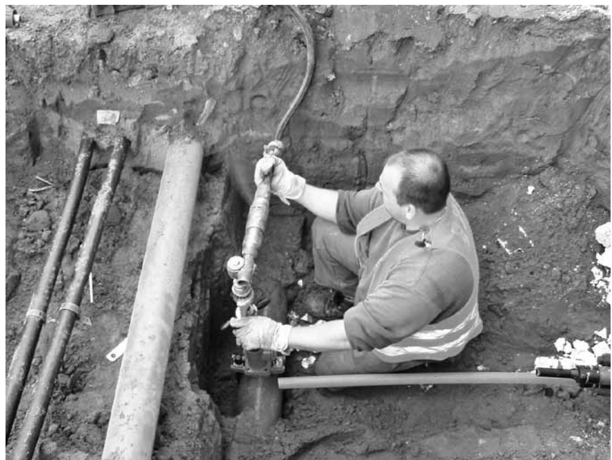
Abbildung D.11: Hauptwasserleitung anbohren
