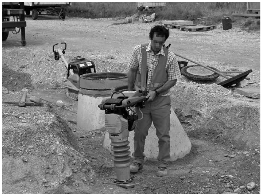
Abbildung D.24: Mit Stampfer verdichten
