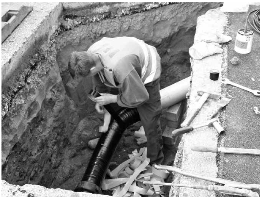
Abbildung D.14: Gasleitung abkleben
