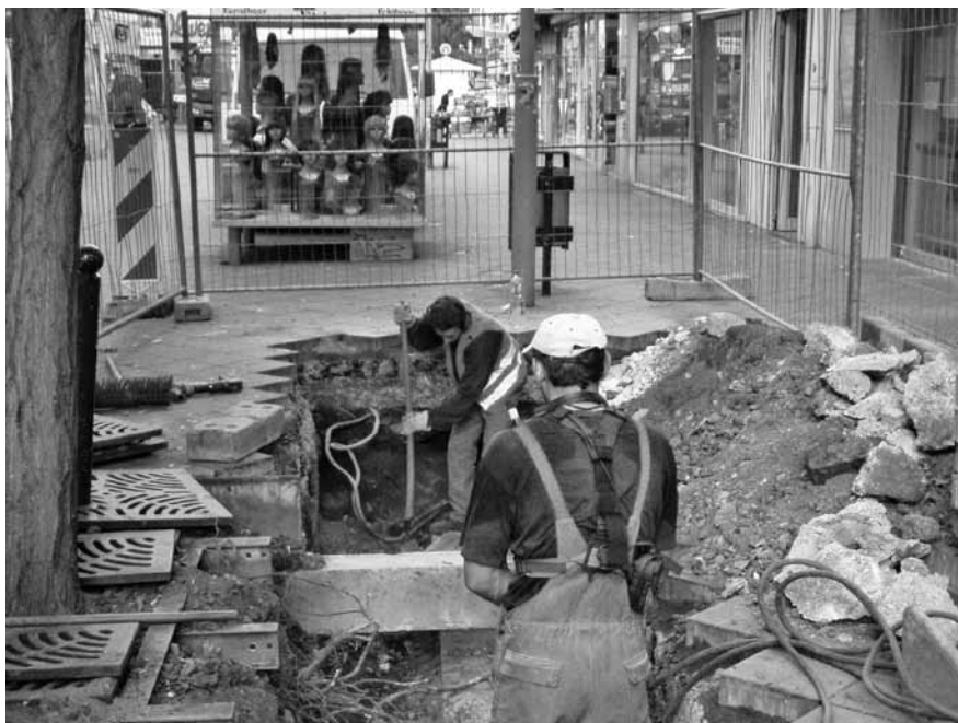
Abbildung D.16: Ausschachtarbeiten
