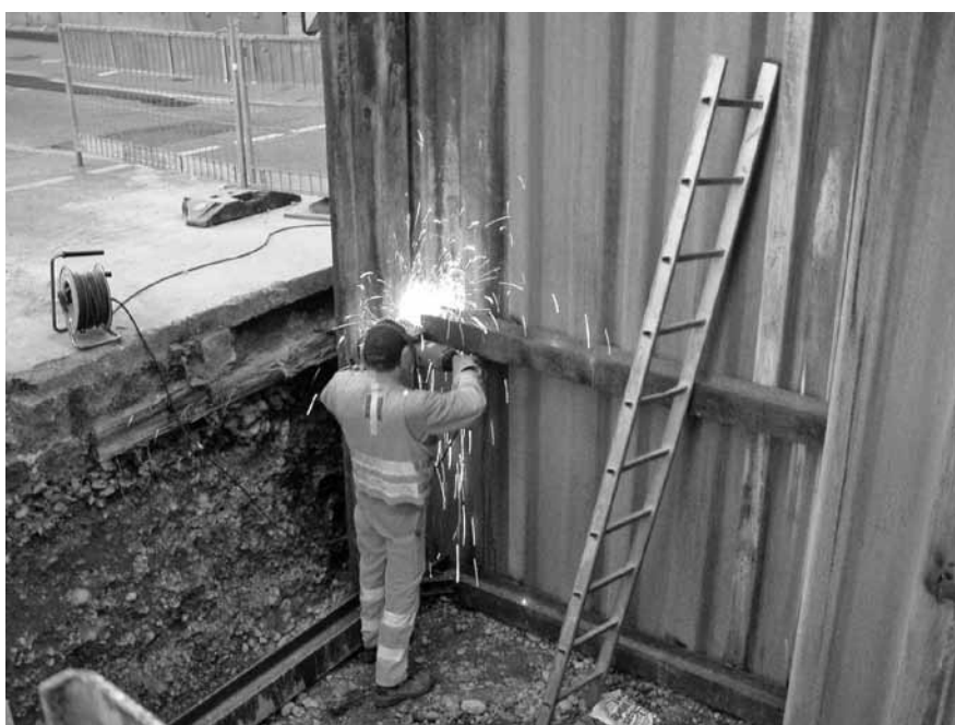
Abbildung D.19: Arbeiten mit Winkelschleifer
