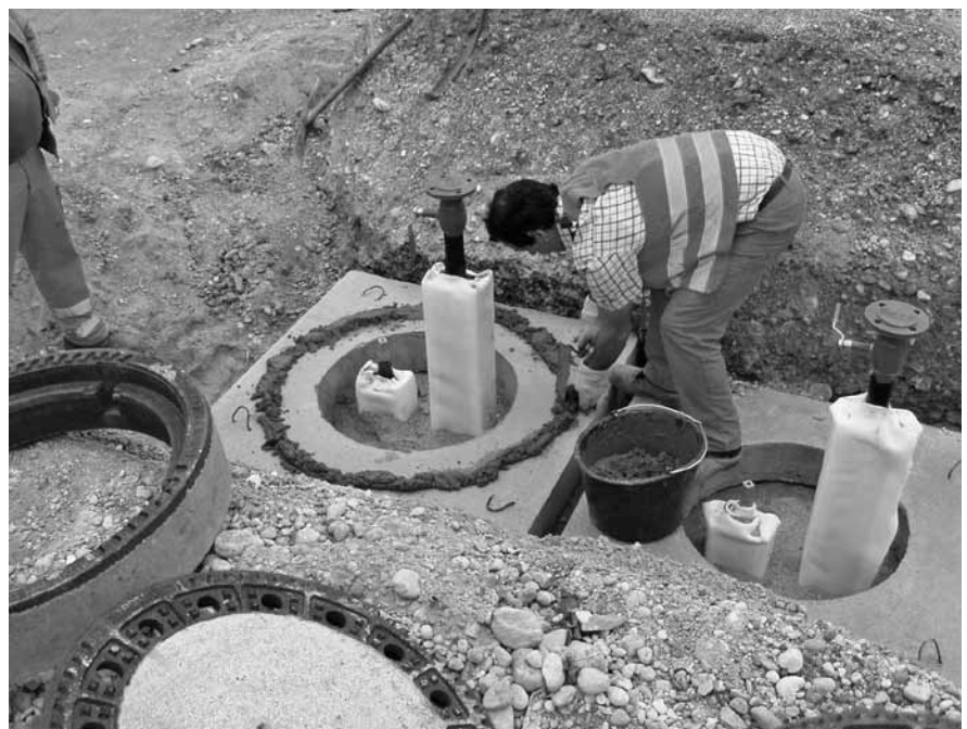
Abbildung D.22: Schachtringe in Beton setzen
