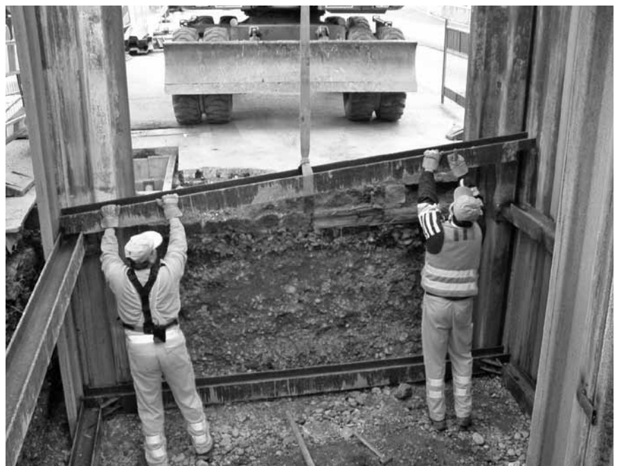
Abbildung D.20: Spundwände setzen
