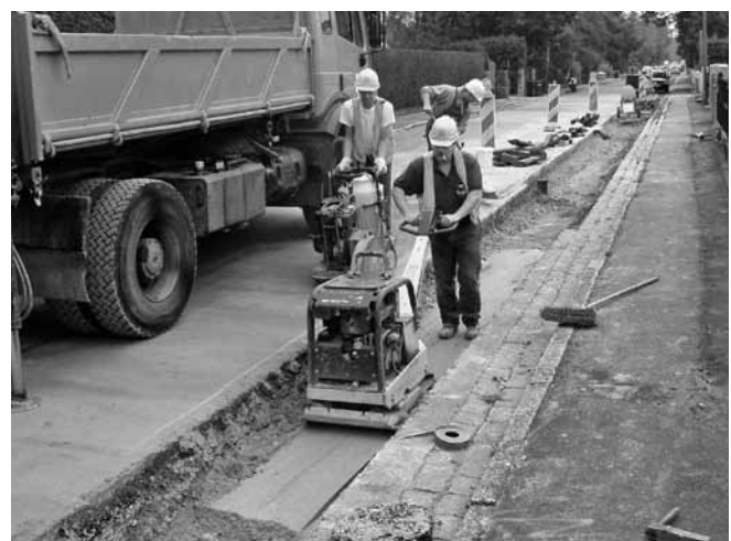
Abbildung D.7: Verdichten mit Rüttelplatte
