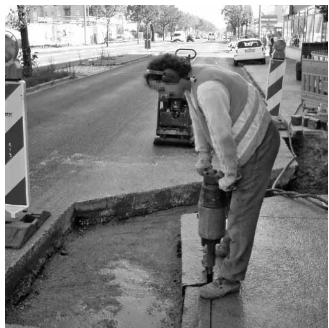
Abbildung D.13: Stemmarbeiten mit Presslufthammer
