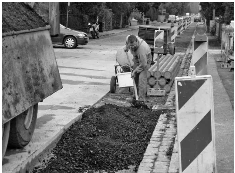
Abbildung D.9: Einbau einer neuen Asphaltdecke
