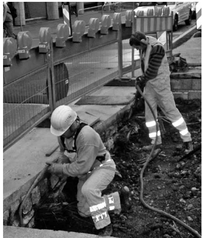
Abbildung D.18: Arbeiten mit Presslufthammer
