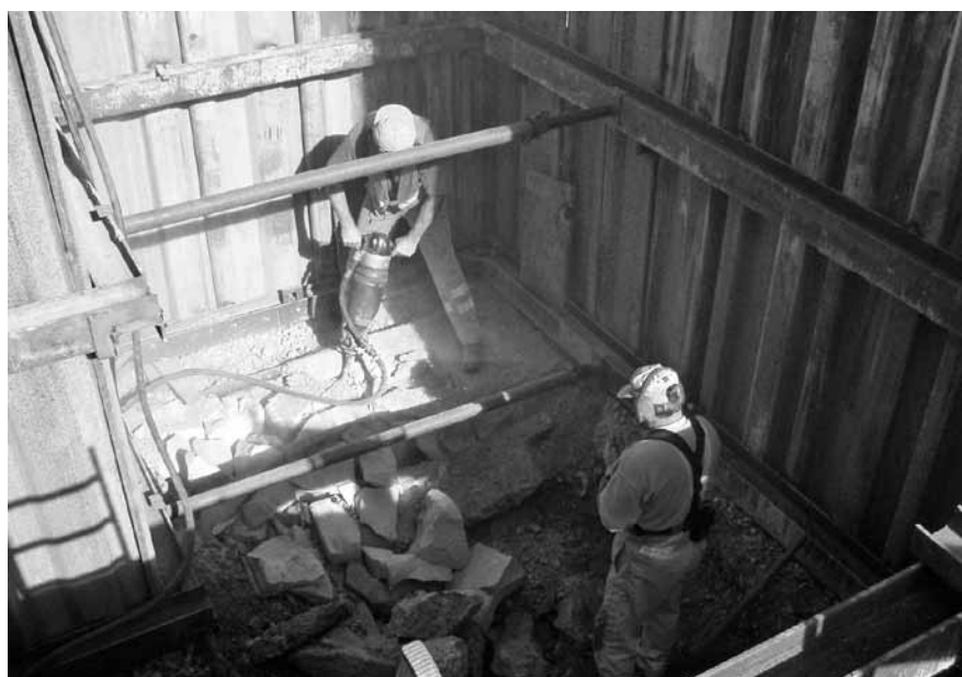
Abbildung D.21: Arbeiten mit Presslufthammer
