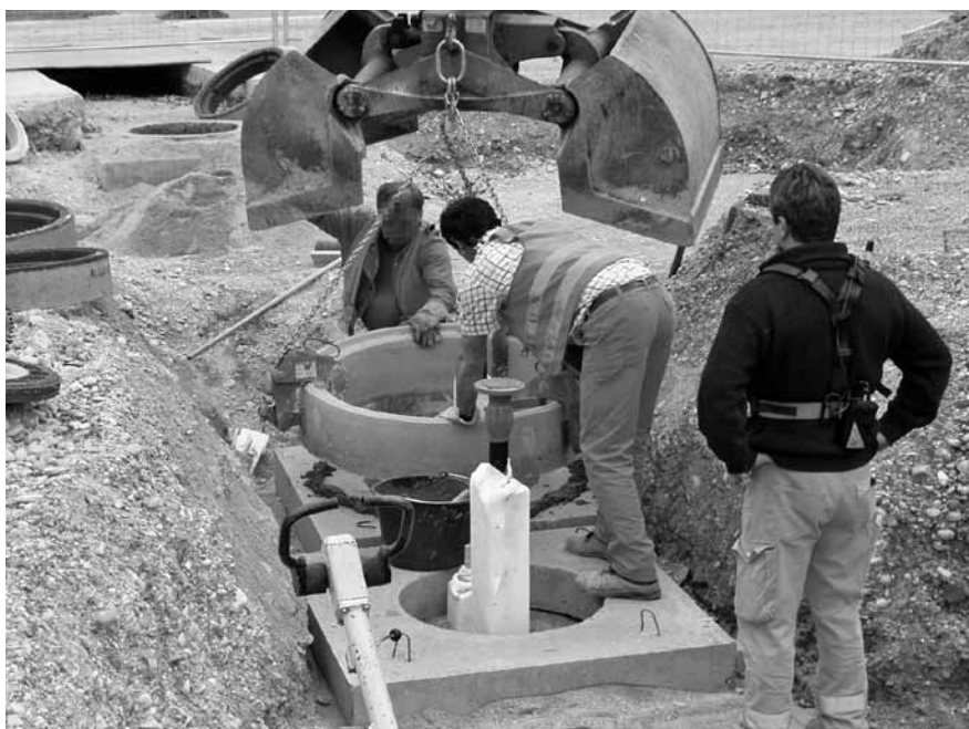
Abbildung D.23: Schachtringe setzen
