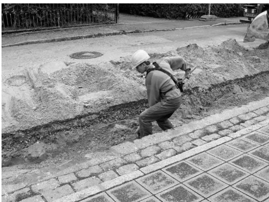
Abbildung D.8: Ausschachtarbeiten
