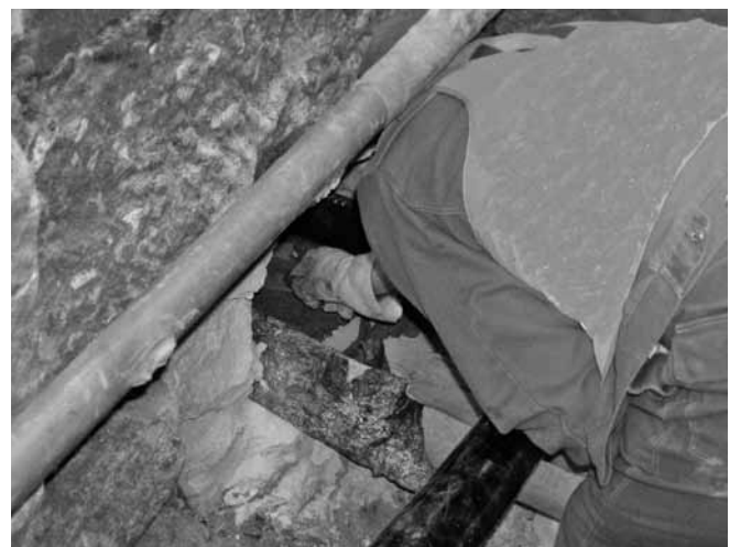
Abbildung D.15: Durchbruch zumauern
