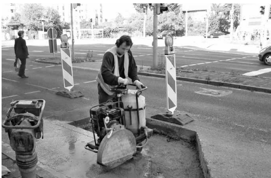
Abbildung D.12: Asphaltdecke schneiden
