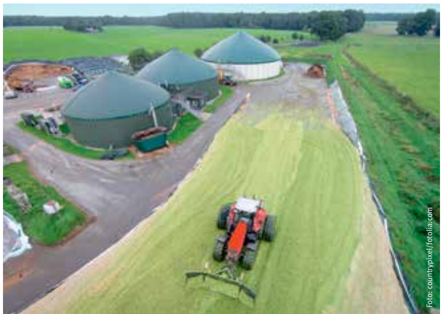
Die Sicherheitsregeln für Biogasanlagen haben sich geändert.
