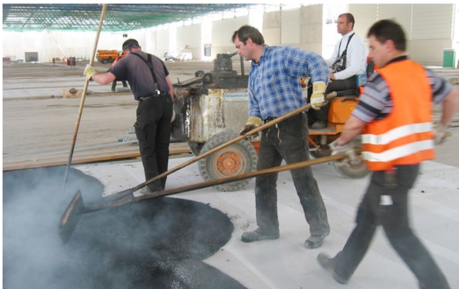
Beschäftigte tragen eine bitumenhaltige Asphaltdecke auf.
