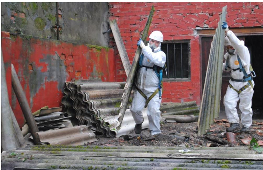
Bis zum Verbot von Asbest wurde Asbestzement auch bei der Herstellung von Dachplatten verwendet.
