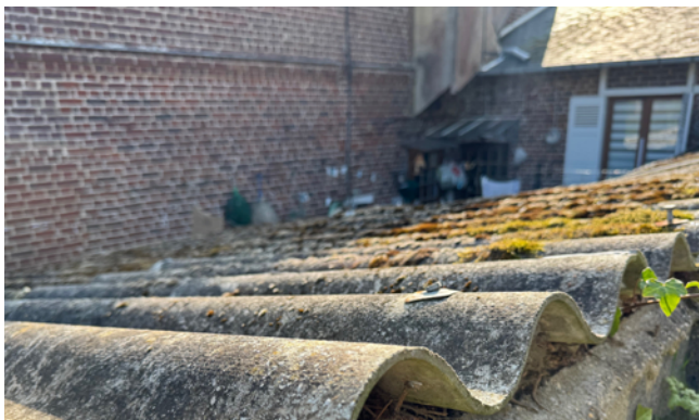
Eternitplatten, die früher als Baustoff unter anderem für Dächer verwendet wurden, wurden bis 1989 unter Verwendung von Asbest hergestellt.
