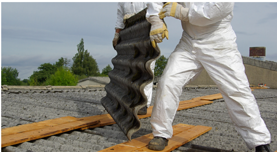
Asbest befindet sich in vielen alten Gebäuden. Bei der Sanierung müssen Beschäftigte eine spezielle, persönliche Schutzausrüstung tragen, um sich vor gefährlichen Schadstoffen wie Asbest zu schützen.
